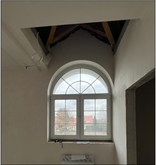
WIDOK NA ISTNIEJĄCE PODWYŻSZENIE SUFITU ZE WZGLĘDU NA OKNO
